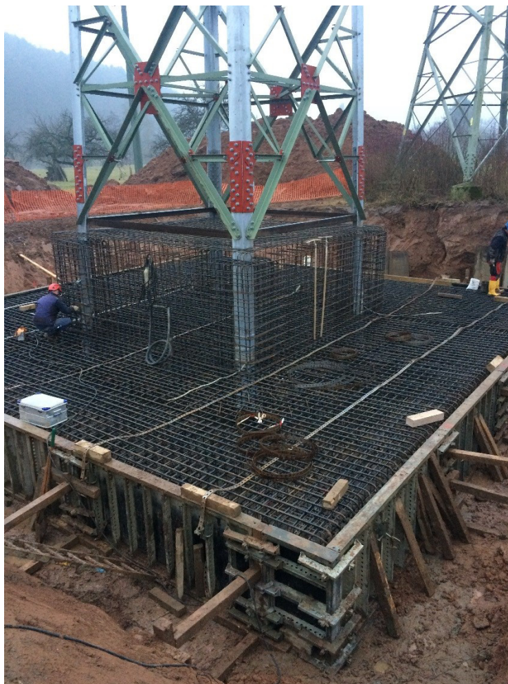
Abbildung 14: Beispiel für Fundamentsanierungsarbeiten, Schalung und Bewehrungsstahl
