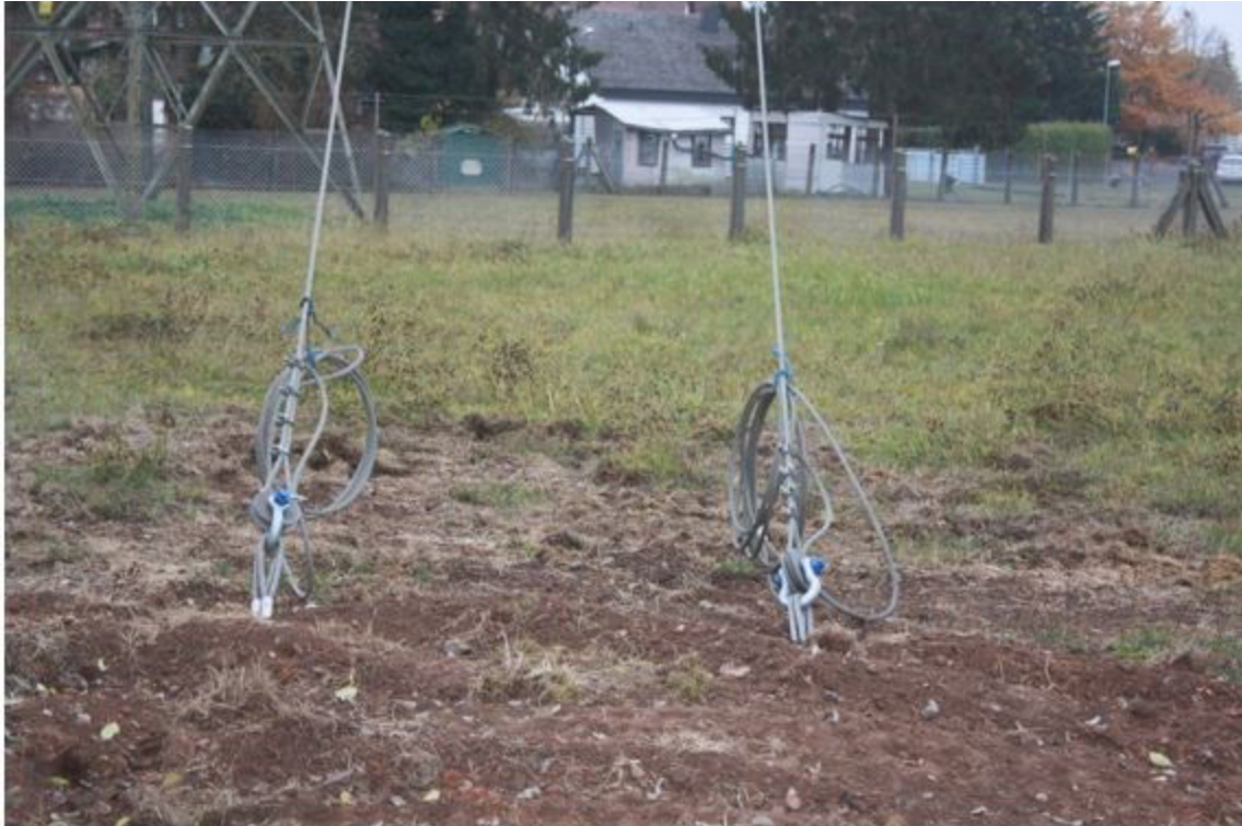
Abbildung 12: Ins Erdreich eingebrachte Anker
