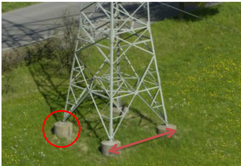
Abbildung 1: Sichtbare Betonfundamentköpfe und Bodenaustrittsmaß
