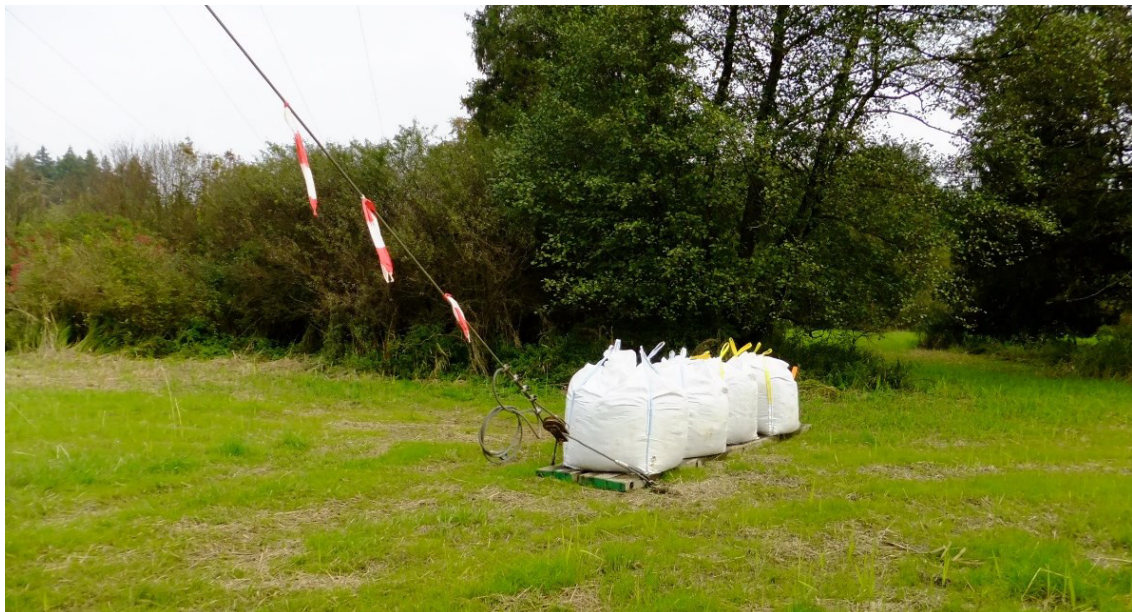
Abbildung 13: Abankerung mittels Ballastschlitten
