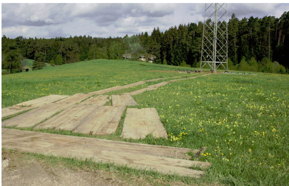
Abbildung 10: Zuwegung über Holzbohlen (leichter Wegebau)
