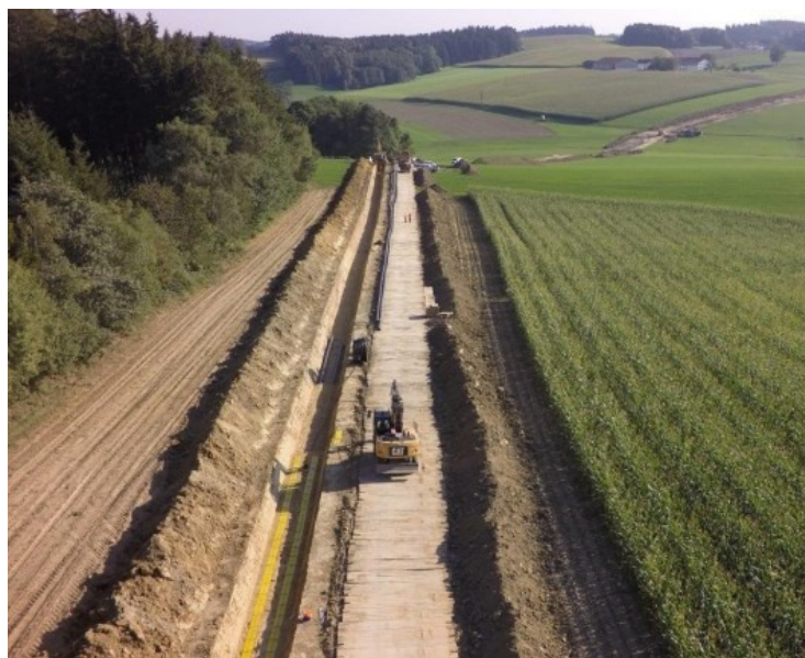
Abbildung 8: Verlegung einer Erdkabelleitung in offener Bauweise
