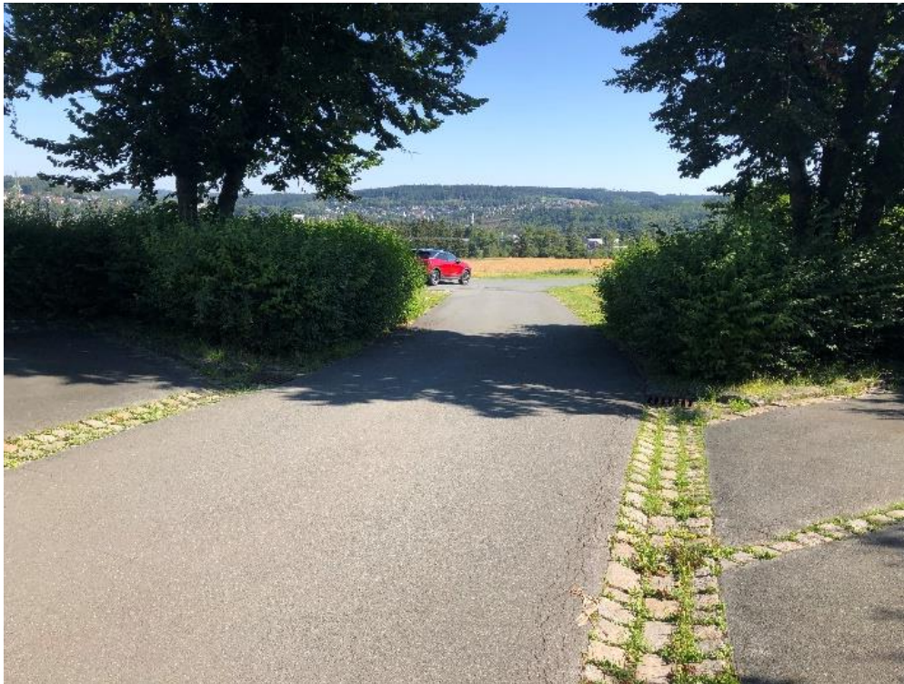
Bild 1: Entwässerung des Parkplatzes des Kinderdorfes Martinsberg über Entwässerungsrinnen und Straßensinkkästen in die Mischwasserkanalisation der Stadt Naila (Blickrichtung: In Richtung Naila)
