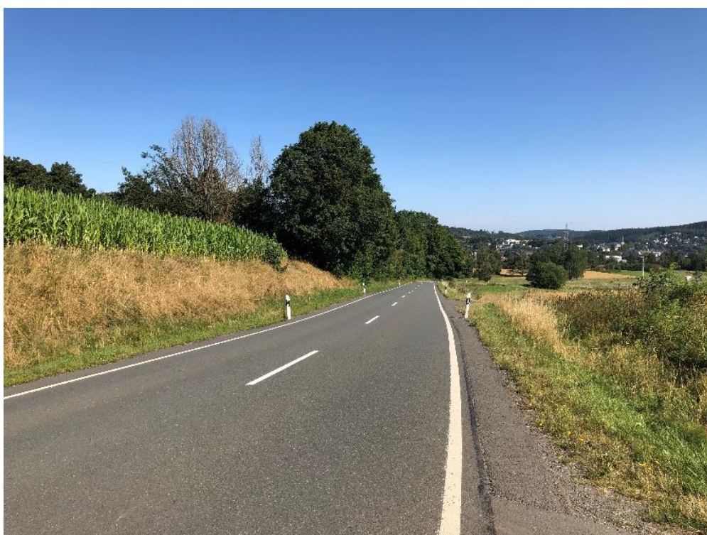
Bild 6: Blick von der Einmündung der St 2158 bei km 0+490 (240_2,803) in Richtung Naila. Auf der linken Seite hinter den Bäumen befindet sich das Kinderdorf Martinsberg
