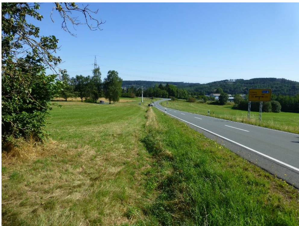
Bild 9: Bestehende Entwässerungsmulde links der St 2158 zur Aufnahme des nicht verunreinigten Wassers eines Teils des Außeneinzugsgebietes A_{E1} (Blick vom Ende der Baustrecke bei Baukm 0+280 (240_ 3,011) in Richtung Naila).
