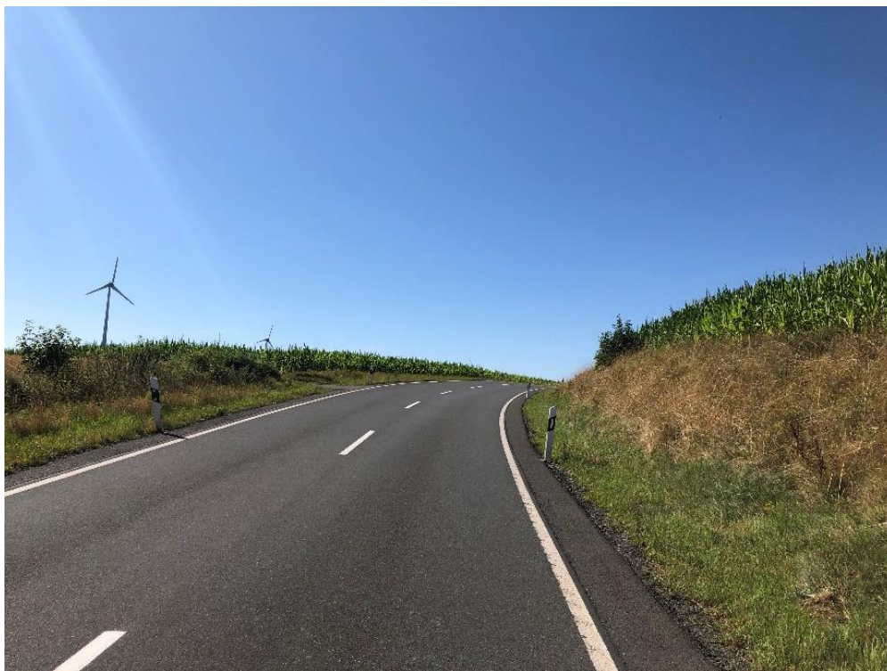
Bild 5: Blick in Richtung Marlesreuth auf den Hochpunkt der St 2158 bei km 0+589 (240_2,702)
