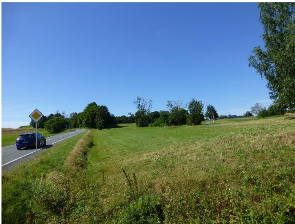
Bild 4: Mulde zur Ableitung des nicht verunreinigten Wassers des Außeneinzugsgebietes zwischen der St 2158 und dem Kinderdorf Martinsberg (Blickrichtung: In Richtung Kinderdorf Martinsberg)
