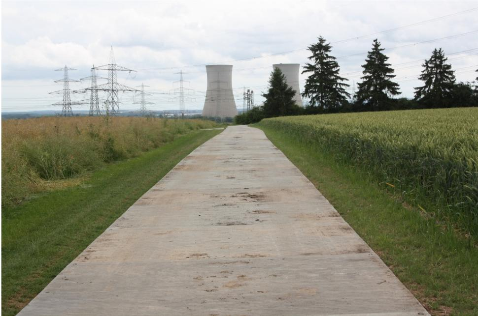
Abbildung 9: Zuwegung über Aluplatten (schwerer Wegebau)
