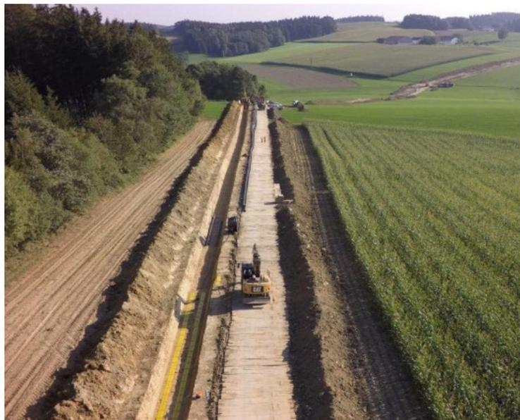
Abbildung 8: Verlegung einer Erdkabelleitung in offener Bauweise
