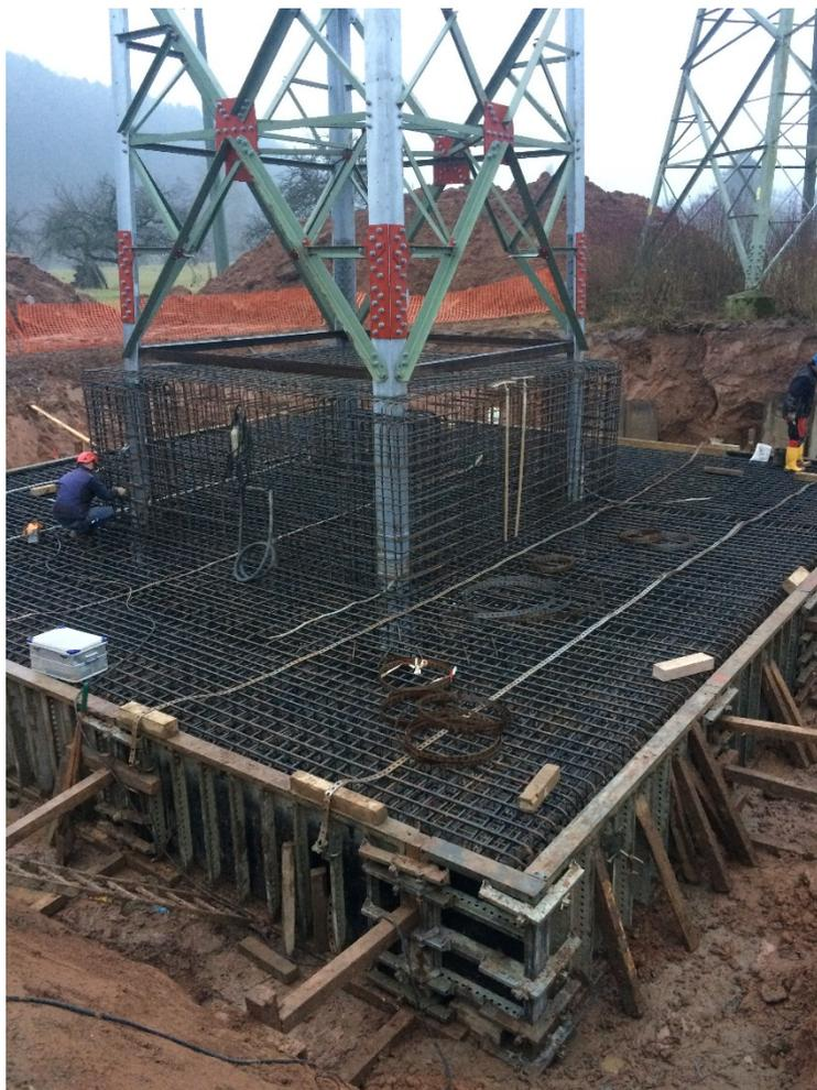
Abbildung 14: Beispiel für Fundamentverstärkungsarbeiten, Schalung und Bewehrungsstahl
