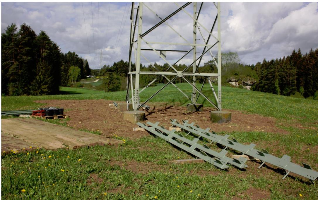
Abbildung 15: Mastverstärkungsteile mit Arbeitsfläche
