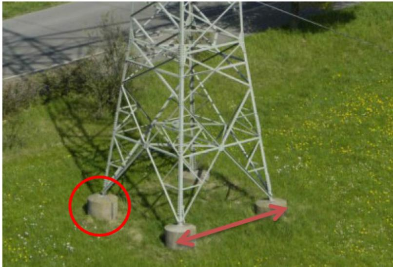
Abbildung 1: Sichtbare Betonfundamentköpfe und Bodenaustrittsmaß
