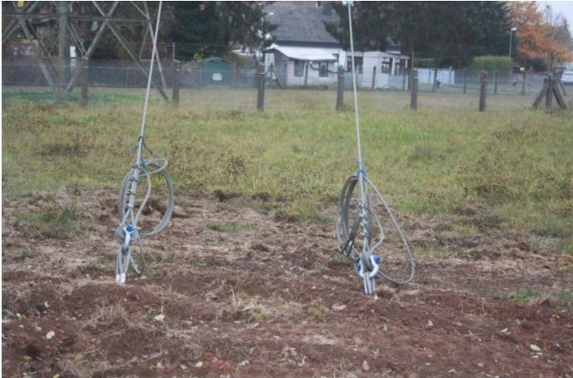
Abbildung 12: Ins Erdreich eingebrachte Anker
