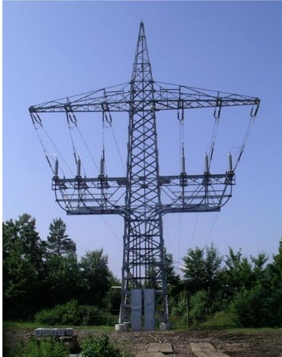
Abbildung 7: Beispiel eines Kabelübergangsmastes
